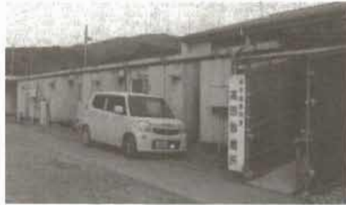
中学校の敷地に立つ診療所 （岩手県陸前高田市で。画像は一部修整しています）
